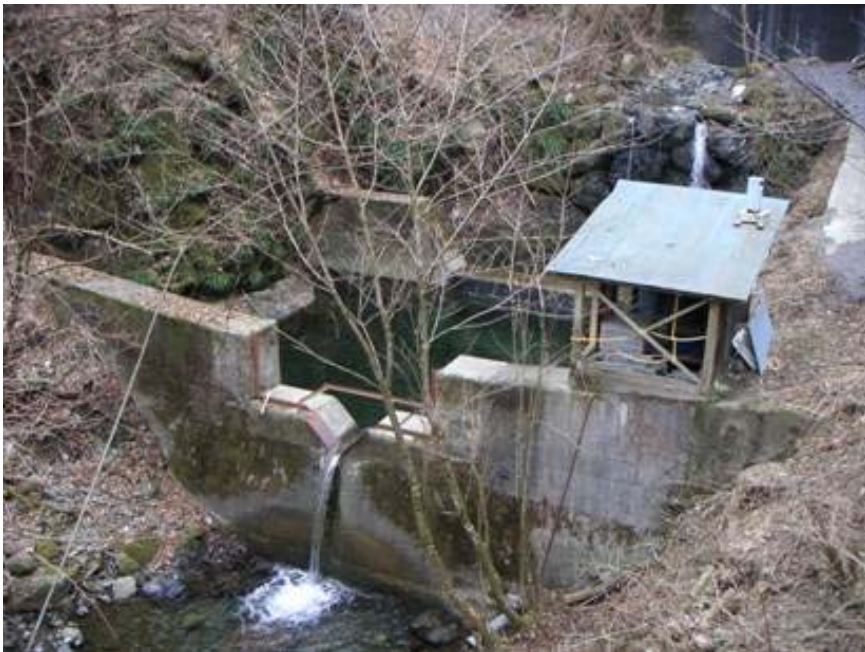
既存の水文観測施設(量水堰)
