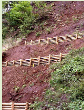
写真 -20 丸太筋工の例
