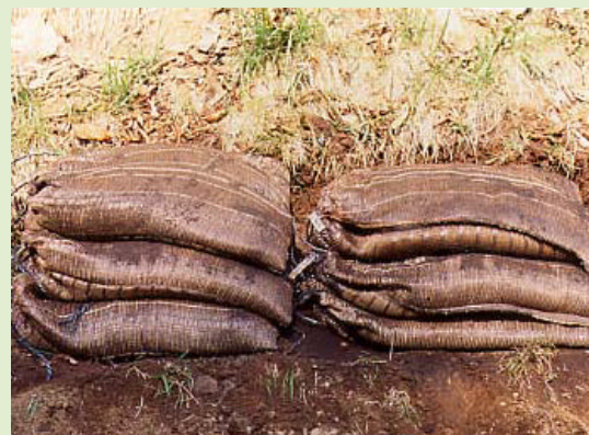
写真 -21 土のう積工の例
