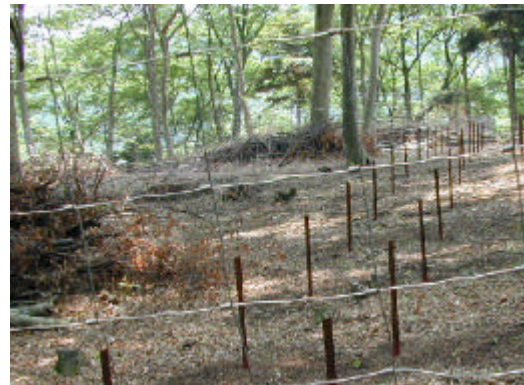
写真 -4 現地に実際に設置された土砂移動量測定枠 (確保森林に設置されたもの)
