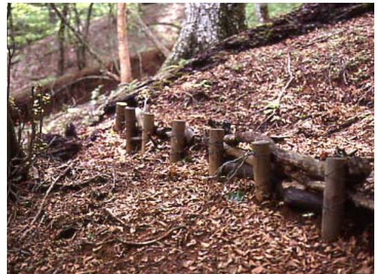
写真 -27 土留め工の例
