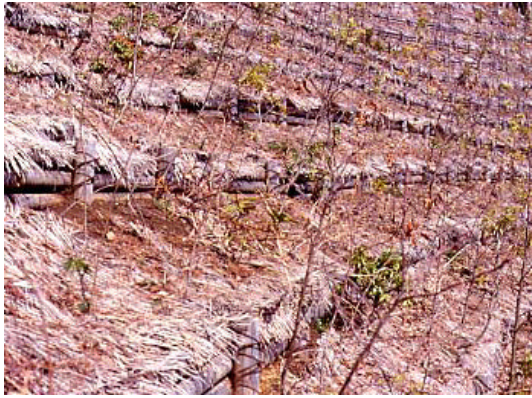
写真 -23 丸太筋工の例
