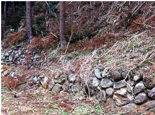
写真 -24 石積み工の例
