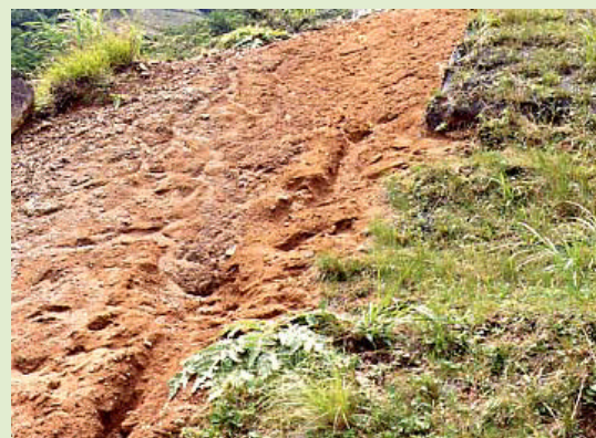
写真 -22 伏工の例
