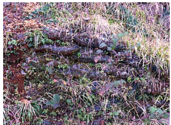
写真 -28 腐食土のう工の例
