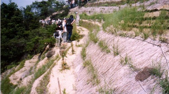
図-10 ワラを斜面表面に引き詰めて浸食を防止する手法(ワラ伏せ工)
