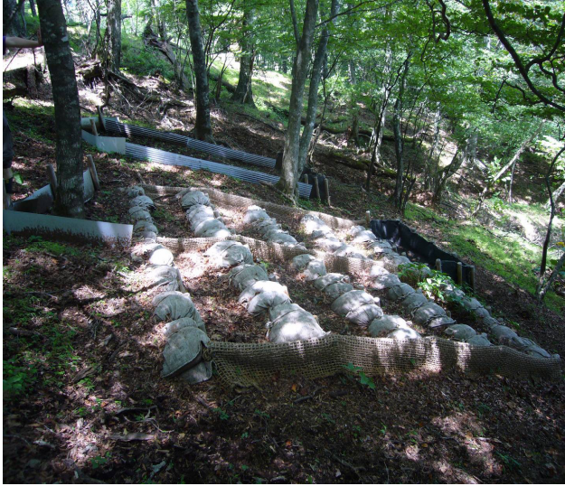
写真-4 リター捕捉土のう積工(麻袋土のう)(2006年8月撮影)
