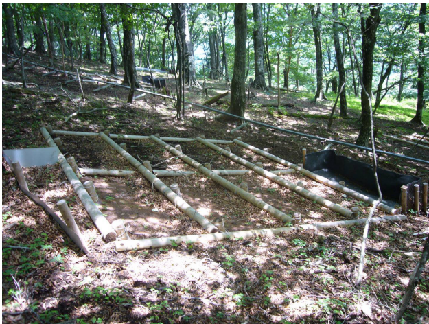
写真-6 木製筋工(竹繊維ネット) (2006年8月撮影)
