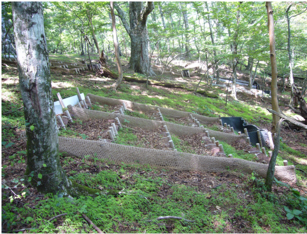
写真-5 リター捕捉土のう積工(竹繊維袋土のう)(2006年8月撮影)
