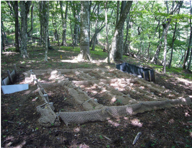
写真-2 リター捕捉ロール工 (A・リター中詰め)(2006年8月撮影)
