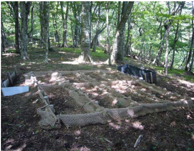
図 2-1-12 リター捕捉ロール工 (A・リター中詰め)(2006年8月撮影)
