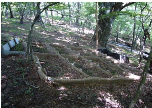
図 2-1-13 リター捕捉ロール工 (B・ネットのみ)(2006年8月撮影)
