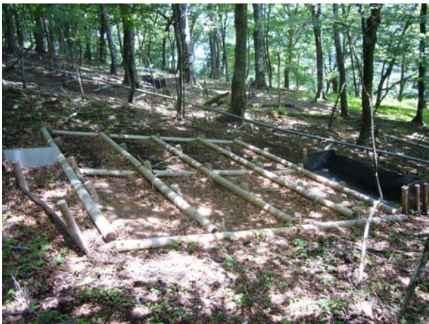
図 2-1-16 木製筋工(竹繊維ネット) (2006年8月撮影)
