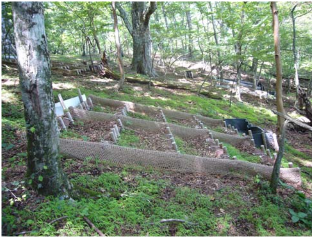
図 2-1-15 リター捕捉土のう積工(竹繊維袋土のう)(2006年8月撮影)
