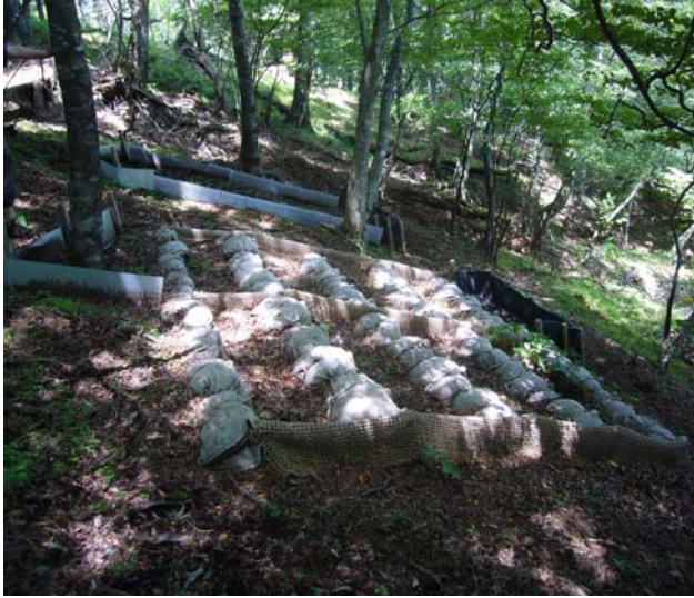
図 2-1-14 リター捕捉土のう積工(麻袋土のう)(2006年8月撮影)
