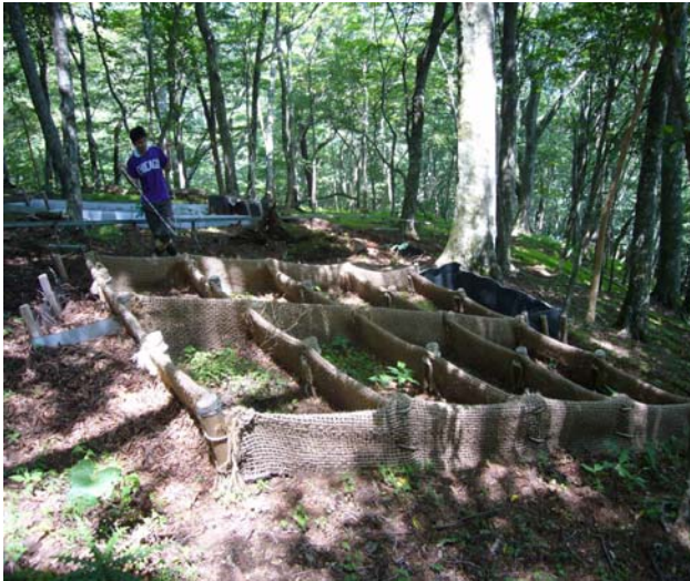
図 2-1-11 リター捕捉ネット工(2006年8月撮影)
