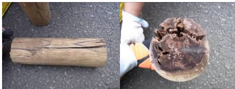
写真4 3年区のスギ被害材の加重部側面（左）と断面（右）
