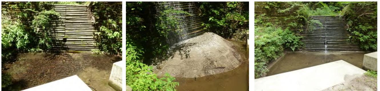
写真3 量水堰の土砂堆積、浚渫の状況（ヌタノ沢A沢）左：H27.7.15 中：H27.7.21 右：H27.9.16
