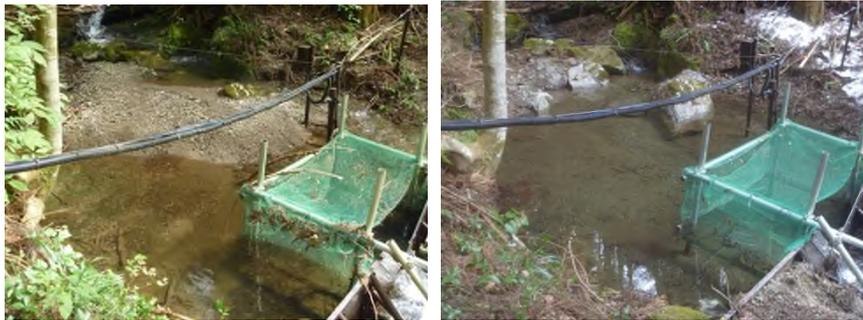
写真2 量水堰の土砂浚渫の状況（貝沢 No4 量水堰） 左：H27.9.15 右：H28.2.3
