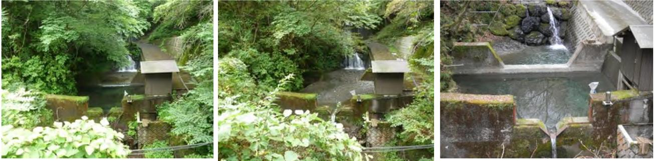
写真1 量水堰の土砂堆積、浚渫の状況（大洞沢） 左：H27.7.8 中：H27.10.5 右：H28.3.28
