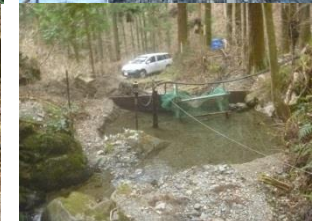
写真 3 貝沢 N01～4 量水堰の土砂堆積、浚渫の状況（上：H29. 11. 1 下：H30. 1. 11） （左から、N01 量水堰・N02 量水堰・N03 量水堰・N04 量水堰）
