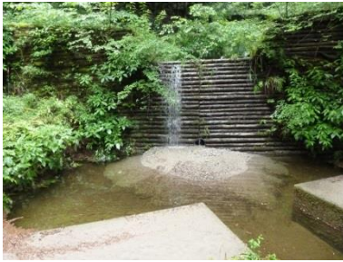
写真 2 ヌタノ沢 A 沢量水堰の土砂堆積、浚渫の状況 左：H29. 8. 8, 中：H29. 9. 12 右：H29. 10. 31
