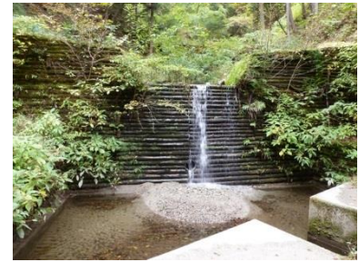
写真 2 ヌタノ沢 A 沢量水堰の土砂堆積、浚渫の状況 左：H29. 8. 8, 中：H29. 9. 12 右：H29. 10. 31
