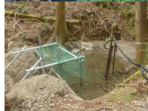
写真 3 貝沢 N01～4 量水堰の土砂堆積、浚渫の状況（上：H29. 11. 1 下：H30. 1. 11） （左から、N01 量水堰・N02 量水堰・N03 量水堰・N04 量水堰）
