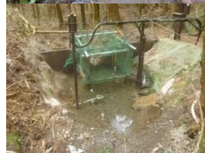
写真 3 貝沢 N01～4 量水堰の土砂堆積、浚渫の状況（上：H29. 11. 1 下：H30. 1. 11） （左から、N01 量水堰・N02 量水堰・N03 量水堰・N04 量水堰）
