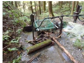
写真 2 ヌタノ沢 A 沢量水堰の土砂堆積、浚渫の状況 左：H29. 8. 8, 中：H29. 9. 12 右：H29. 10. 31
