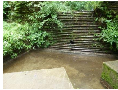
写真 2 ヌタノ沢 A 沢量水堰の土砂堆積、浚渫の状況 左：H29. 8. 8, 中：H29. 9. 12 右：H29. 10. 31
