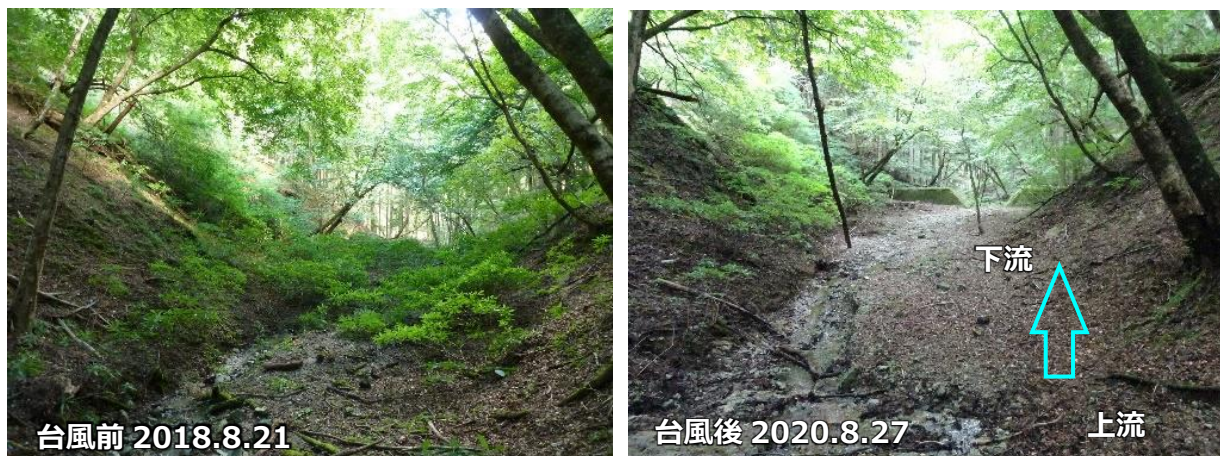
図-3 B 沢の源頭部に繁茂してきていたミツマタの流出
