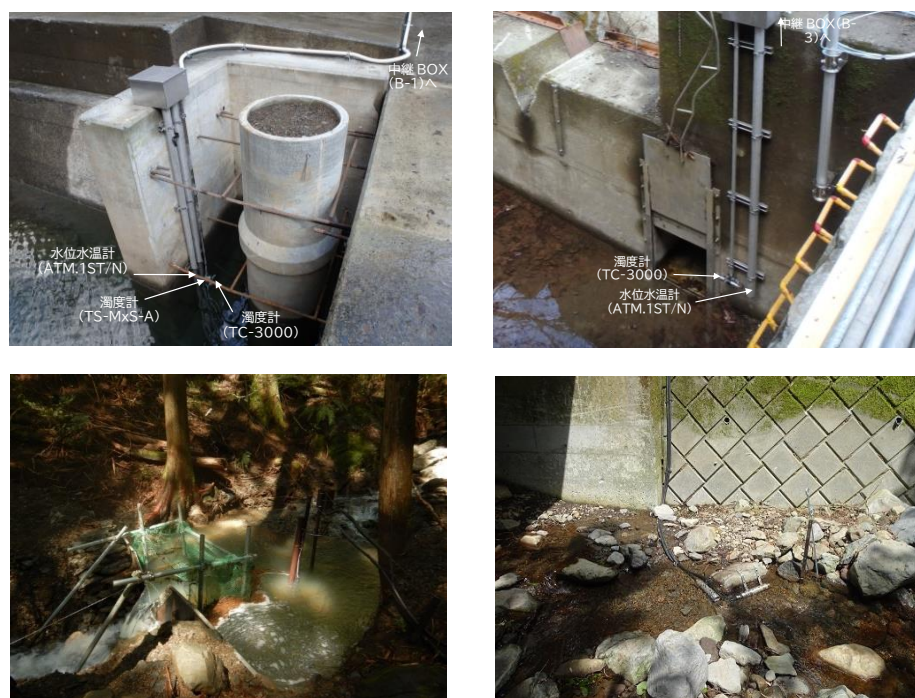
図-1 観測施設復旧状況（上：大洞沢、左下：貝沢、右下：フチジリ沢）
