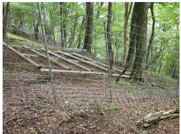
写真V-18 植生保護柵との組み合わせ
