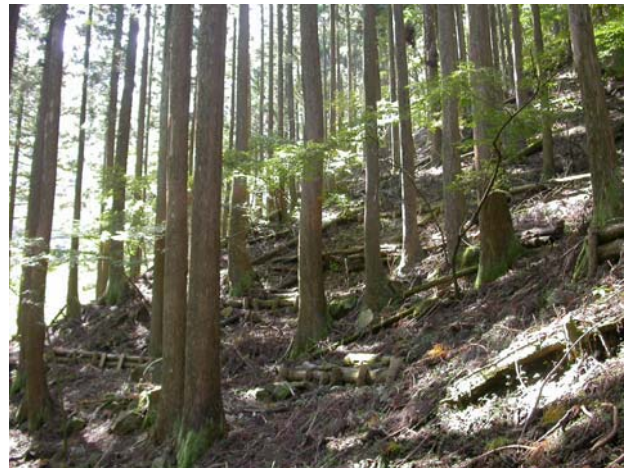
写真V-16 間伐材を利用した丸太筋工
