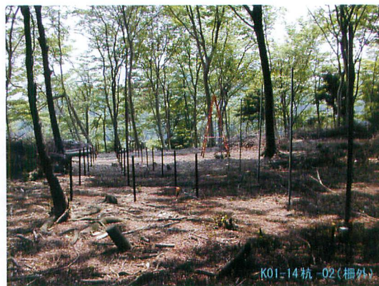
写真 14 モニタリングのための測定杭の設置状況
