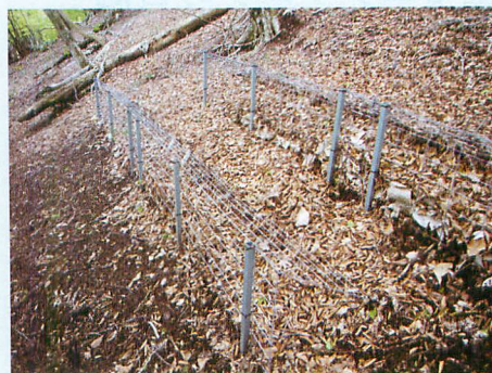
写真10 金網筋工
