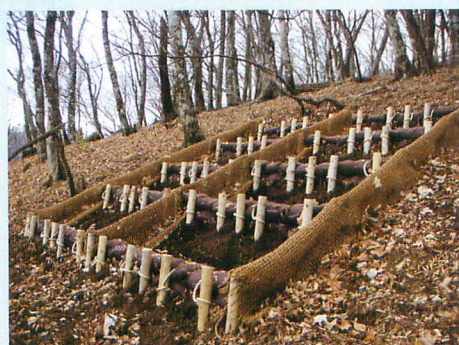
写真11 リター捕捉土のう積工
