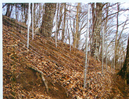
写真12 小面積の植生保護柵(イノシシ柵タイプ)
