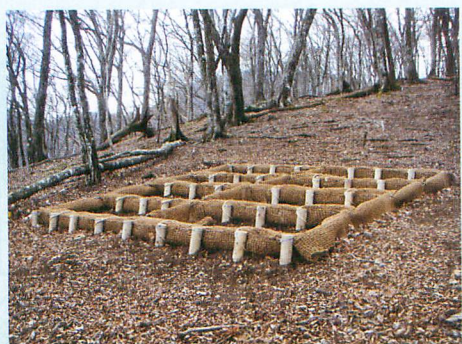
写真9 リター捕捉ロール工
