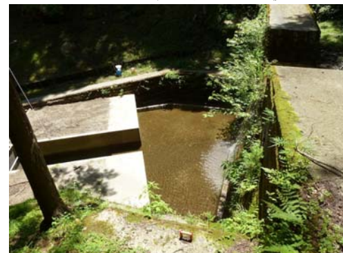
ヌタノ沢 2 回目施工後
