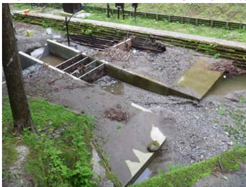
ヌタノ沢 1 回目施工前
