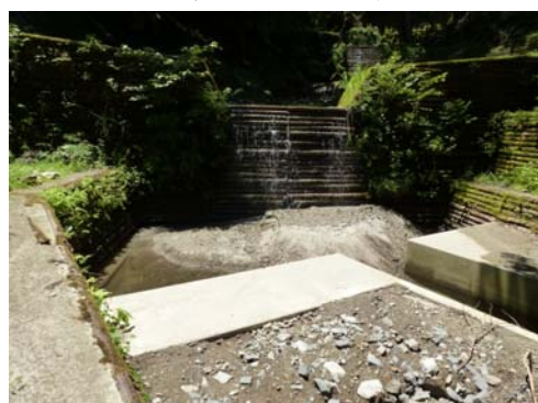
ヌタノ沢 2 回目施工前
