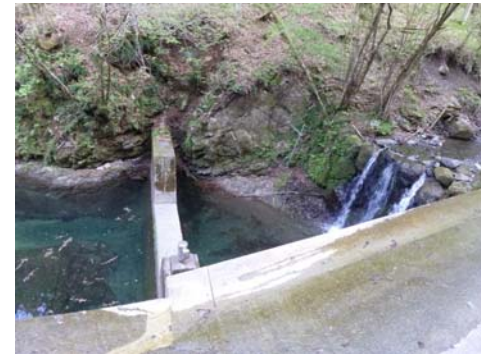
大洞沢 2 回目施工後
