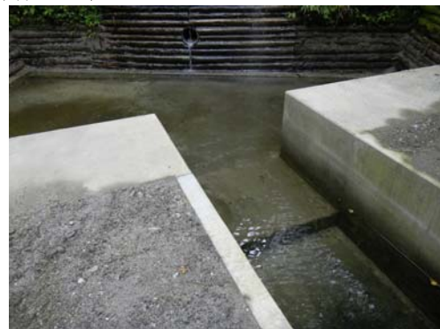
ヌタノ沢 1 回目施工後
