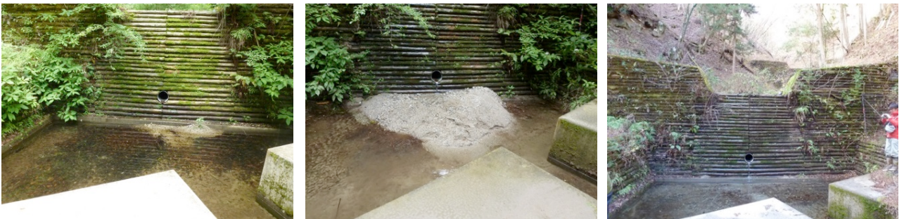
図3 量水堰の土砂堆積、浚渫の状況 (ヌタノ沢A沢) 左 : H28. 7. 13 中 : H28. 8. 29 右 : H28. 12. 15
