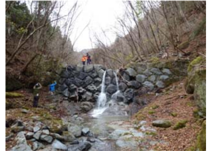
山地保全のための堰堤の建設
