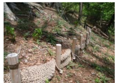
土壌保全工の施工
